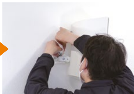
Cableado con ambas manos
