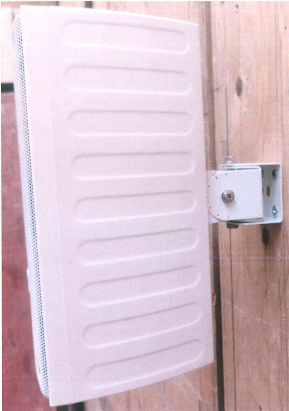
Bild 2 Wandbefestigung Lautsprechersystem "TZ-206W"
